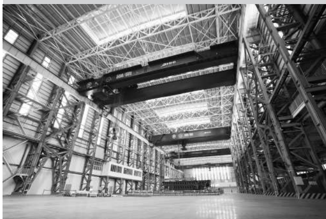
大型地震工程模拟研究设施
