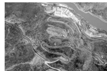
桂花带领村民参与修建的海拔2400米的盘山公路。
