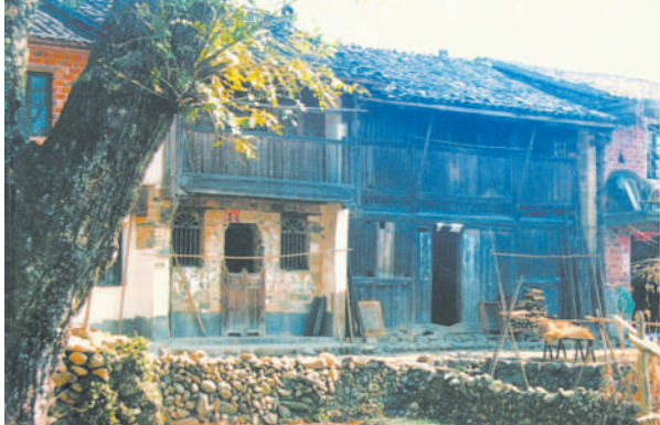
年，江西宁都小布木屋。一九三一年，第一期无线电训练班学员在小木屋学习居住。作者供图
