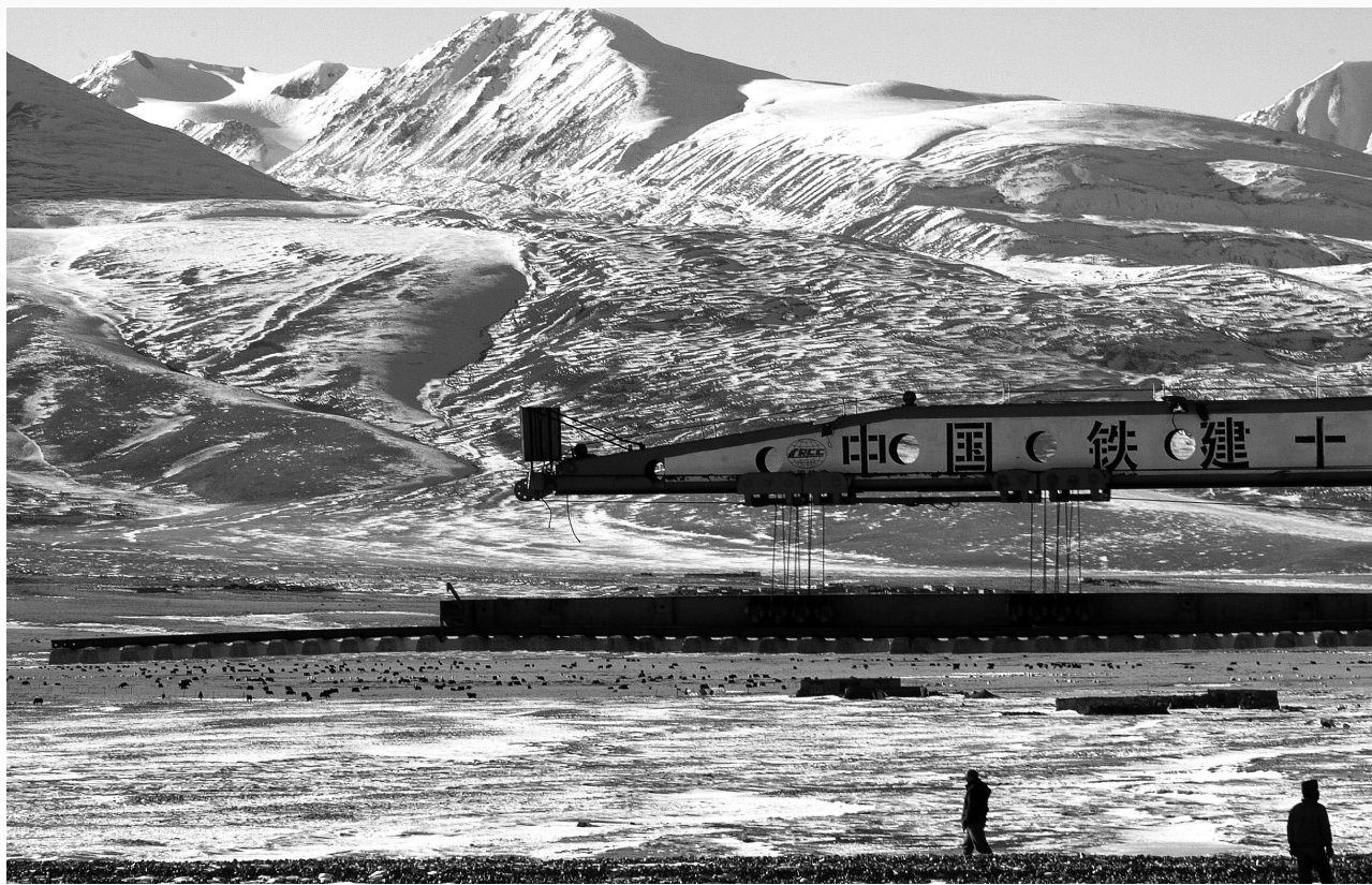
青藏铁路在铺轨建设中(2004年12月5日摄)。
