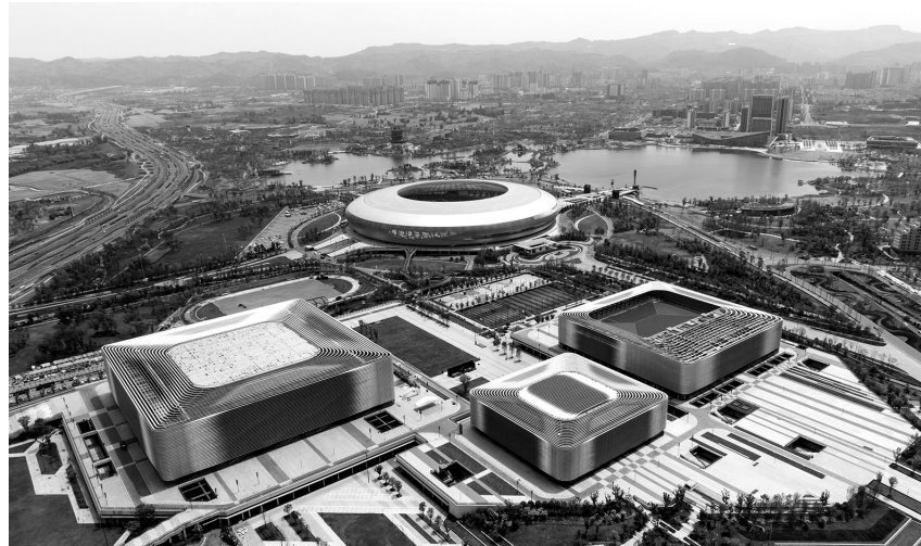
第31届世界大学生夏季运动会将于7月28日至8月8日在中国成都举行。这是4月18日拍摄的东安湖体育公园主体育场(后)、多功能体育馆(前左)、游泳跳水馆(前右)和小球馆(前中)。
