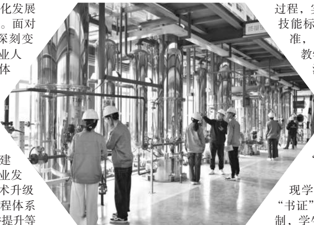
学校丙烯酸酯半实物仿真生产实训车间现场教学场景
