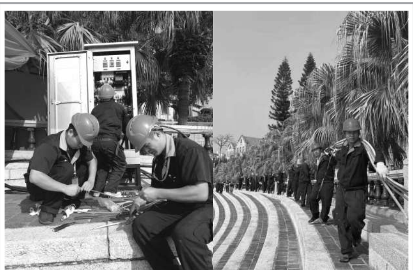
水电维修部职工在抢修电力设备
